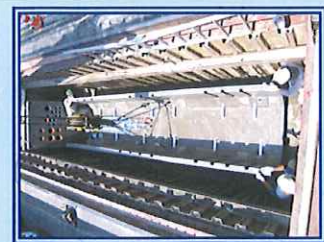
マンホール据付
