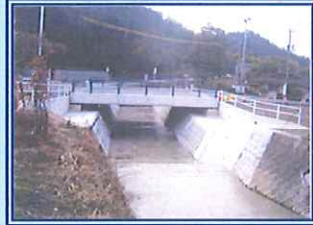
橋台工及び橋桁工
